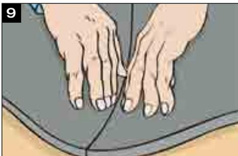
Zum Verteilen des Klebers auf große Flächen einen Spachtel oder eine Lammfell-Rolle benutzen. Auch hier sollte der Kleber sparsam aufgetragen werden. Nach ausreichender Abluftzeit kann das Plattenmaterial auf der zu isolierenden Fläche aufgebracht werden.
