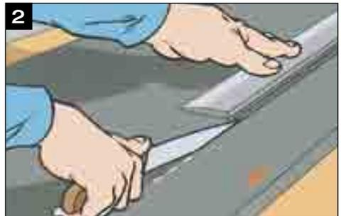
Ein kurzes Stück der Schutzfolie von der Platte lösen.
