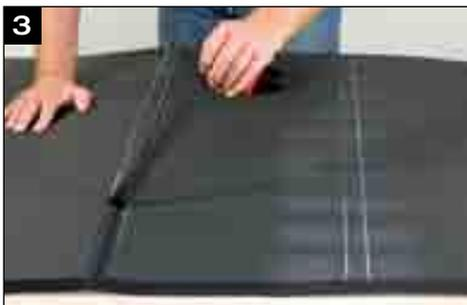
Die entstandenen Fugen mithilfe einer Kleberpumpe mit KAIFLEX Spezialkleber versehen und ablüften lassen.
