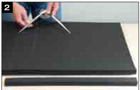
Äußere und innere Höhe des Rohrwinkels abtragen und mit einem Zirkel (U/2-Zirkelspanne), Schnittkanten anhand eines Kreisbogens verbinden.
