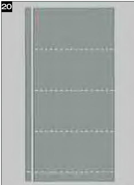
Von der Vorderseite des Ventils bis zum Isoliermantel die maximale und minimale Länge des zweiten Mantels ausmessen.
