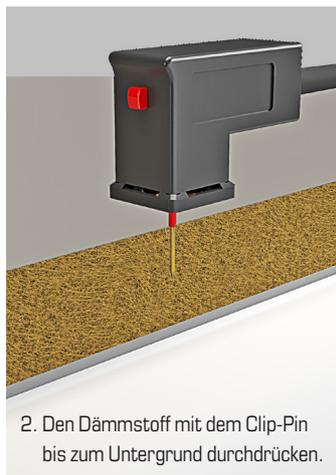
2. Den Dämmstoff mit dem Clip-Pin bis zum Untergrund durchdrücken.
